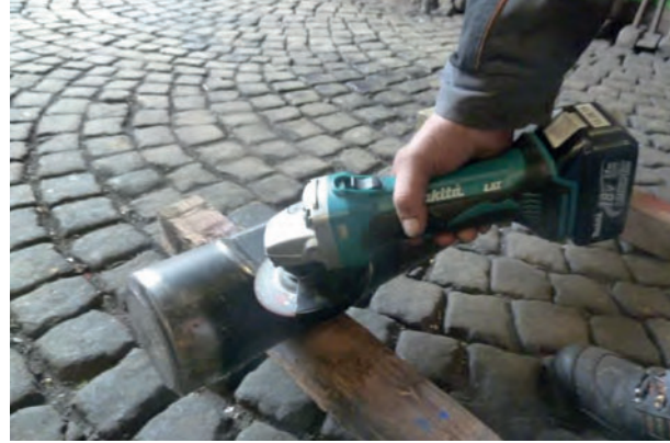
das Entgraten erfolgt mit einer Flex
