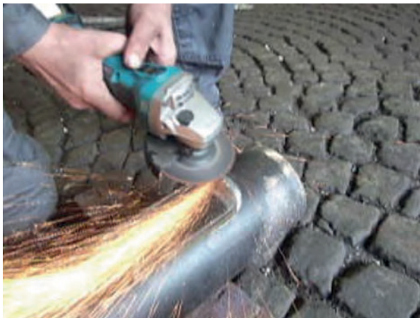
das Entgraten muss um das Bord / Haltenut erfolgen
